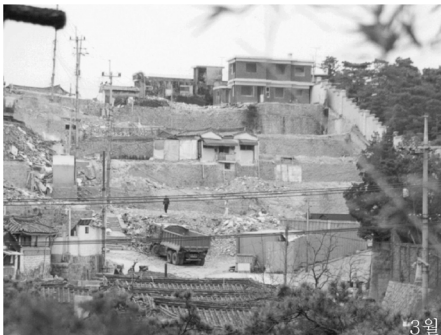
가회동 주거환경개선지구 한옥 철거사례
