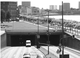
지하차로 설치 (뒤셀도르프, 독일)
